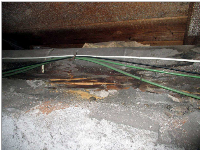
foto 11, 12: Pozednice resp. krokev v oblasti střední části uliční obvodové stěny poškozené dřevokazným hmyzem
