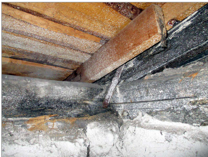
foto 15: Hmyzem poškozená pozednice v oblasti JV nároží
