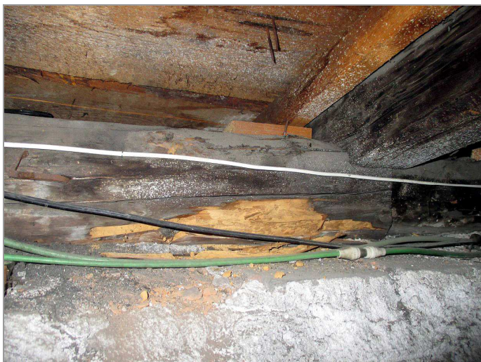
foto 13, 14: Pozednice resp. krokev v oblasti střední části uliční obvodové stěny poškozené dřevokazným hmyzem
