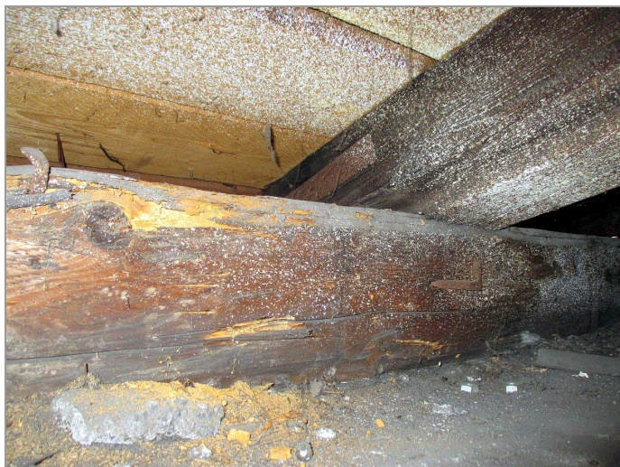
foto 9, 10: Pozednice v oblasti SV nároží poškozené dřevokazným hmyzem
