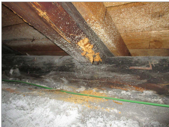
foto 13, 14: Pozednice resp. krokev v oblasti střední části uliční obvodové stěny poškozené dřevokazným hmyzem
