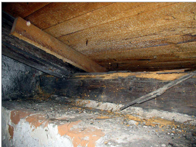
foto 7, 8: Pozednice resp. krokev v oblasti SZ nároží poškozené dřevokazným hmyzem
