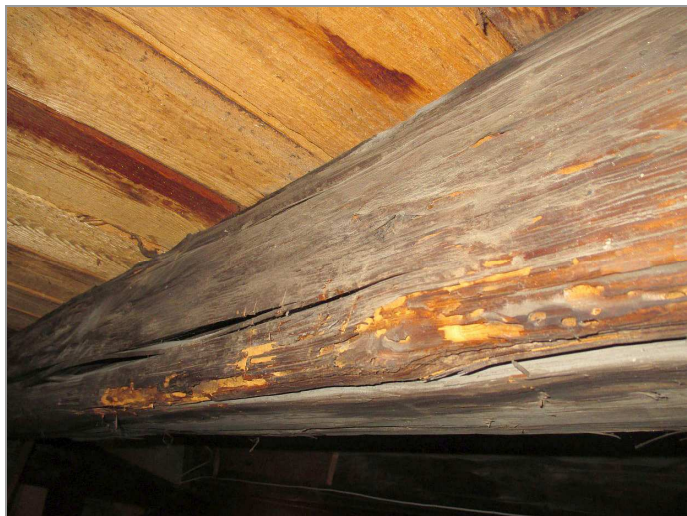
foto 11, 12: Pozednice resp. krokev v oblasti střední části uliční obvodové stěny poškozené dřevokazným hmyzem
