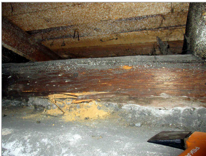
foto 9, 10: Pozednice v oblasti SV nároží poškozené dřevokazným hmyzem
