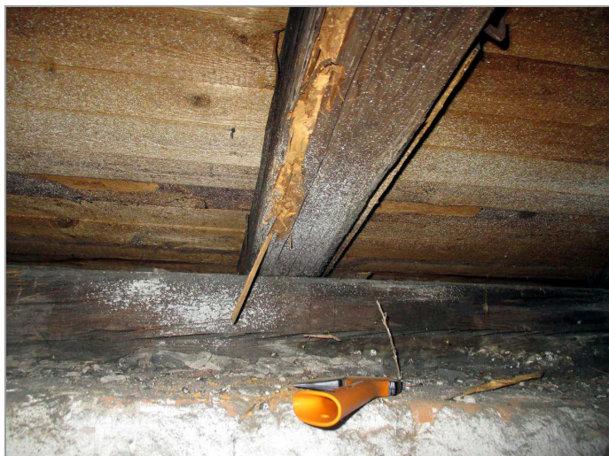
foto 7, 8: Pozednice resp. krokev v oblasti SZ nároží poškozené dřevokazným hmyzem
